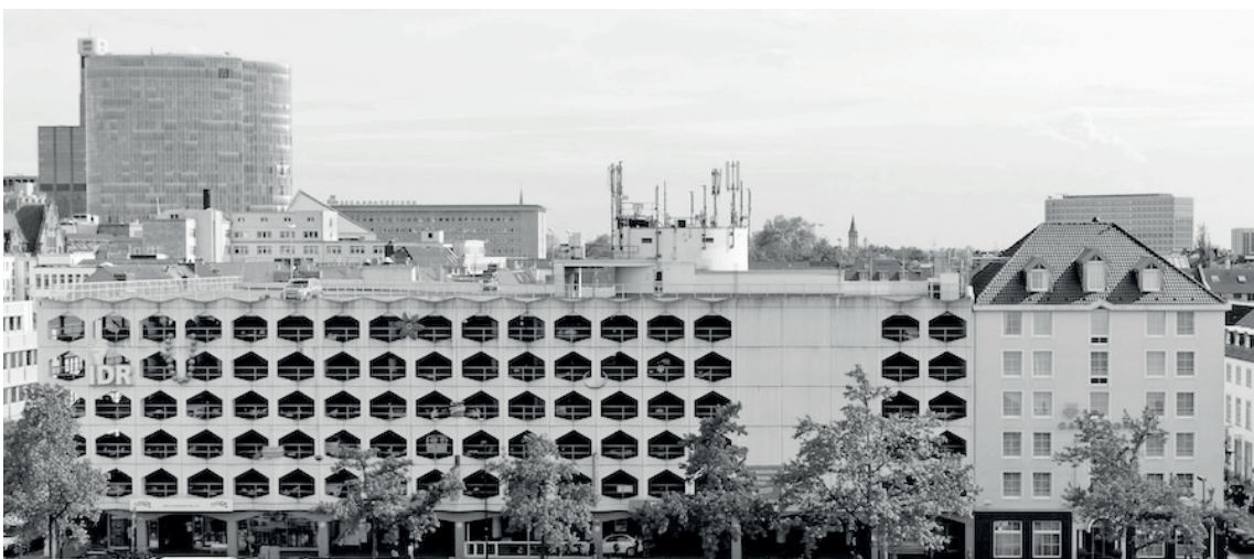
Abbildung 22 Foto vom Bestandsgebäude, Quelle: https://www.carlsplatz-markt.de/der-markt [Zugriff am 19.01.2024]
